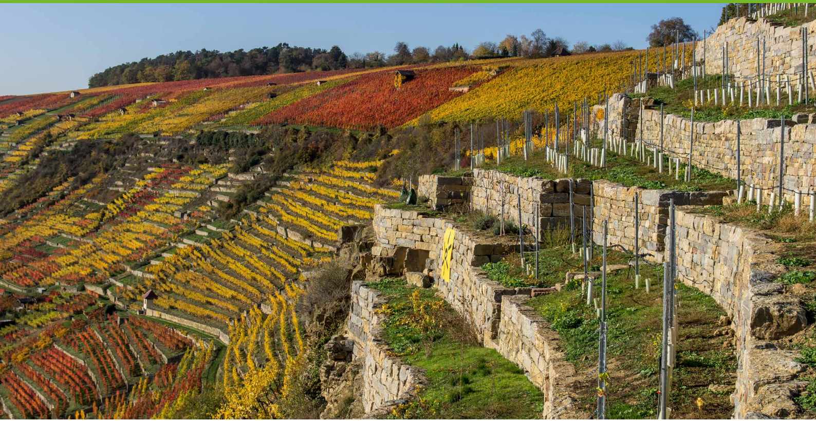
Ansicht der sanierten Mauern im Herbst 2020
