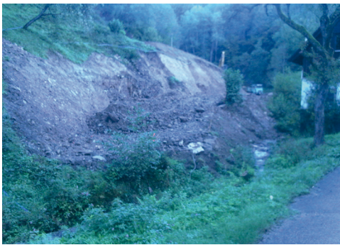
Schwarzwaldverfahren, Hausach vorher
